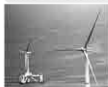
福島県沖約20kmに設置された洋上風力発電機
