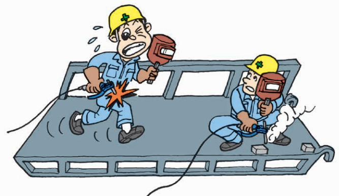
Kesetrum karena batang las menyentuh pinggang sewaktu sedang bekerja di bidang besi miring
