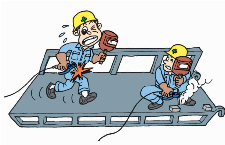
制作钢制斜面时,焊接棒接触到侧腹部导致触电
